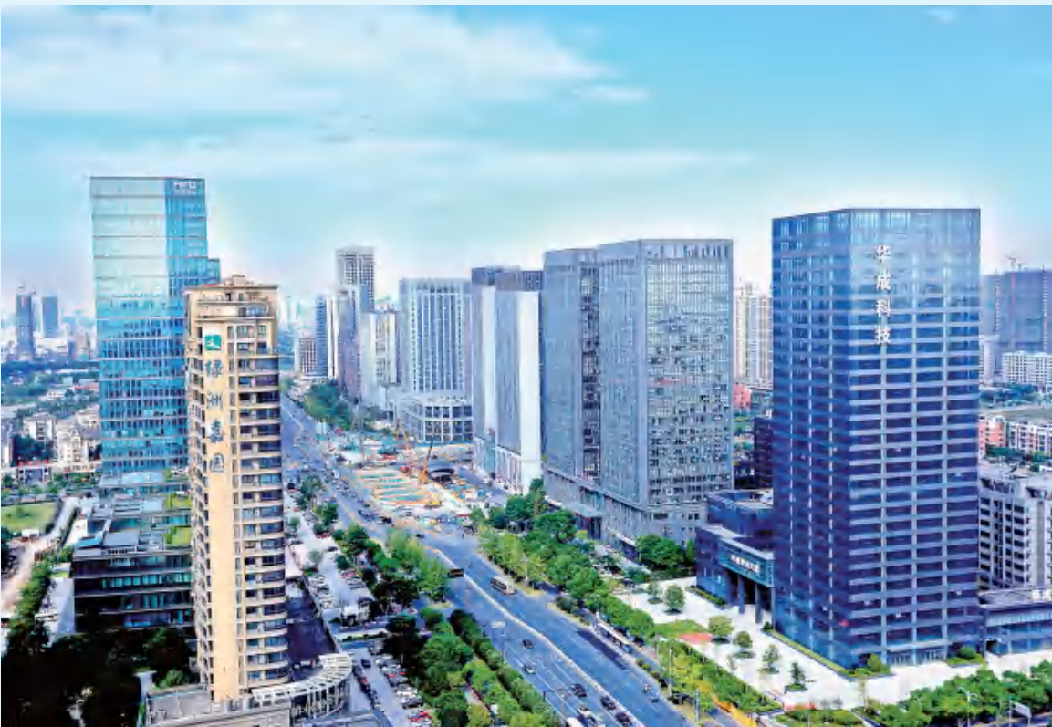
图中中心施工区域即为博奥路站。（现已开通）
